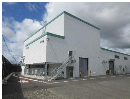
稼働中のセルロースナノファイバー商業プラント
